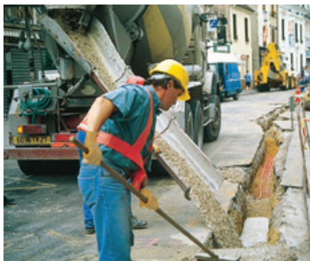
➤ Remblayage en zone urbaine
