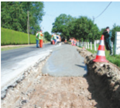
↳ Mise en œuvre du MACES en poutre de rive
