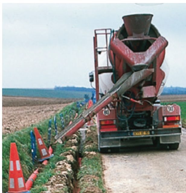
➤ Remblayage de mini-tranchée sous accotement
