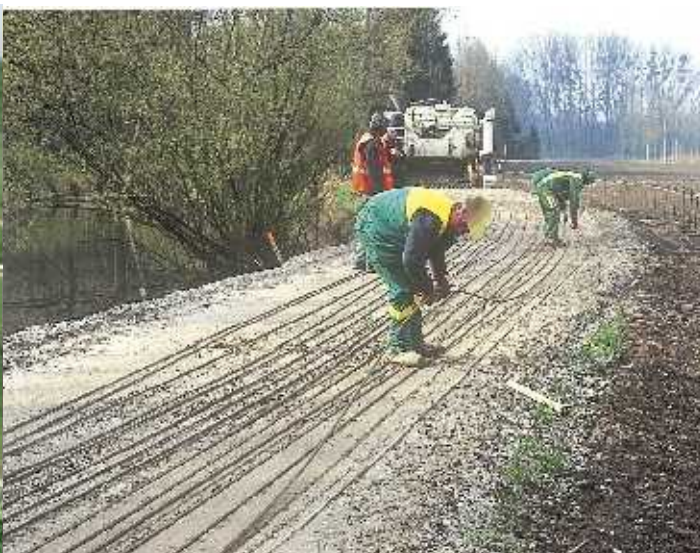
Réalisation d'une piste cyclable en Béton Armé Continu à Strasbourg (67) ▲
