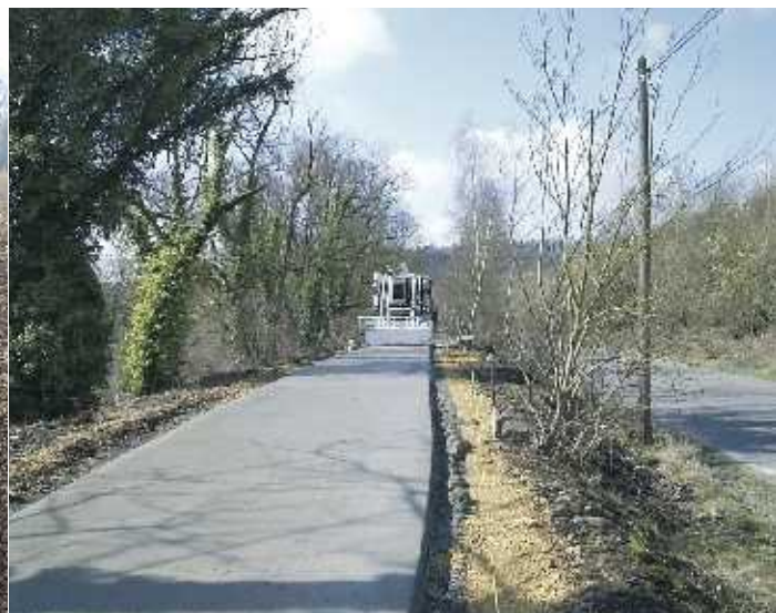
Coulage d'une piste cyclable en Moselle (57) ▲
