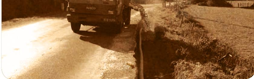
**Les matériaux autocompactants sont des matériaux hydrauliques spécialement élaborés pour ne pas nécessiter de compactage lors de leur mise en œuvre dans les tranchées: ils se mettent en place par simple déversement, sans vibration.**
