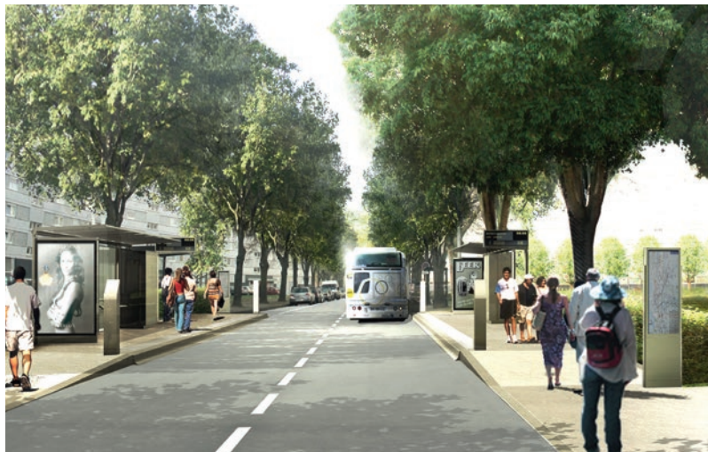
Communauté urbaine de Strasbourg • BHNS ligne G : la plate-forme du BHNS en site partagé, au niveau d'une station de la rue Lavoisier, est réalisée en béton armé continu d'épaisseur 22 cm.
