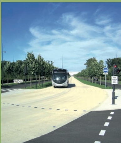
Melun/Sénart • BHNS TZen : revêtement en béton armé continu sur une fondation en béton maigre.
