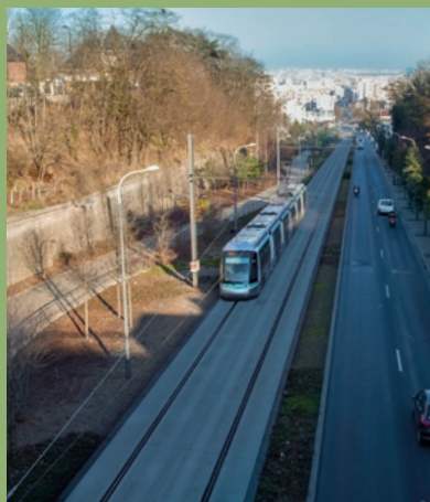
Châtillon/Viroflay • Tramway sur pneus T6 : dalle en béton à joints goujonnés sur une fondation en béton compacté ou en béton maigre.
