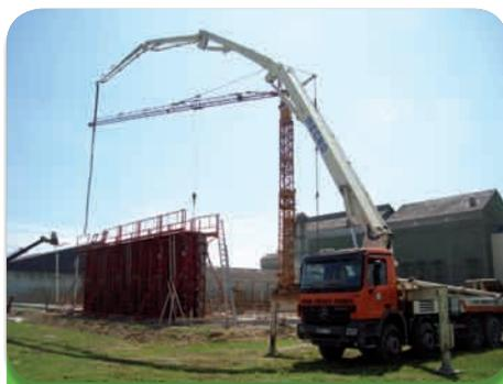
Mise en place d'un béton autoplaçant à la pompe
