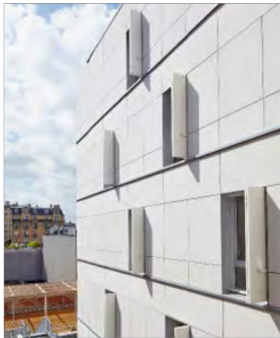
Crèche collective - Paris (Bélus & Hénocq architectes)
