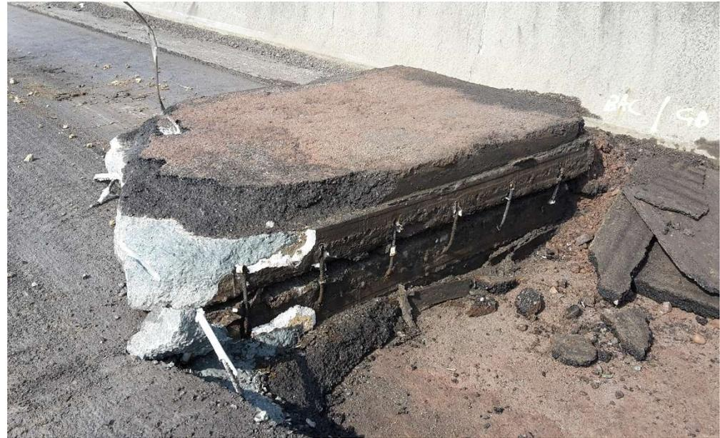
**Illustration du collage entre le béton et la grave bitume après 15 ans**
