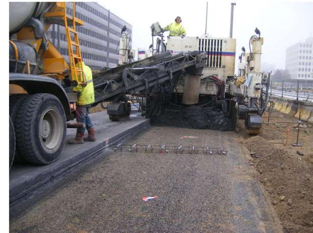
Positionnement des goujons sur des paniers avant le bétonnage
