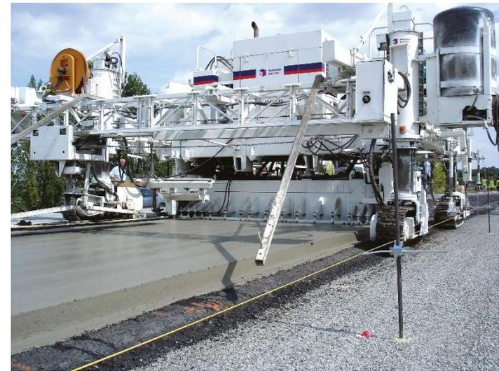
**Mise en œuvre du béton à l'aide d'une machine à coffrages glissants**
