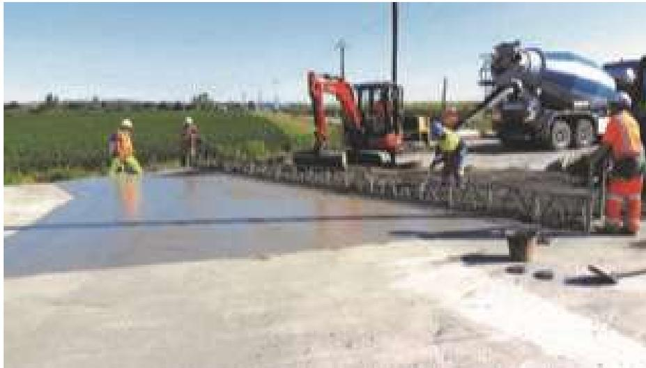
**Mise en œuvre du béton à la poutre vibrante**
