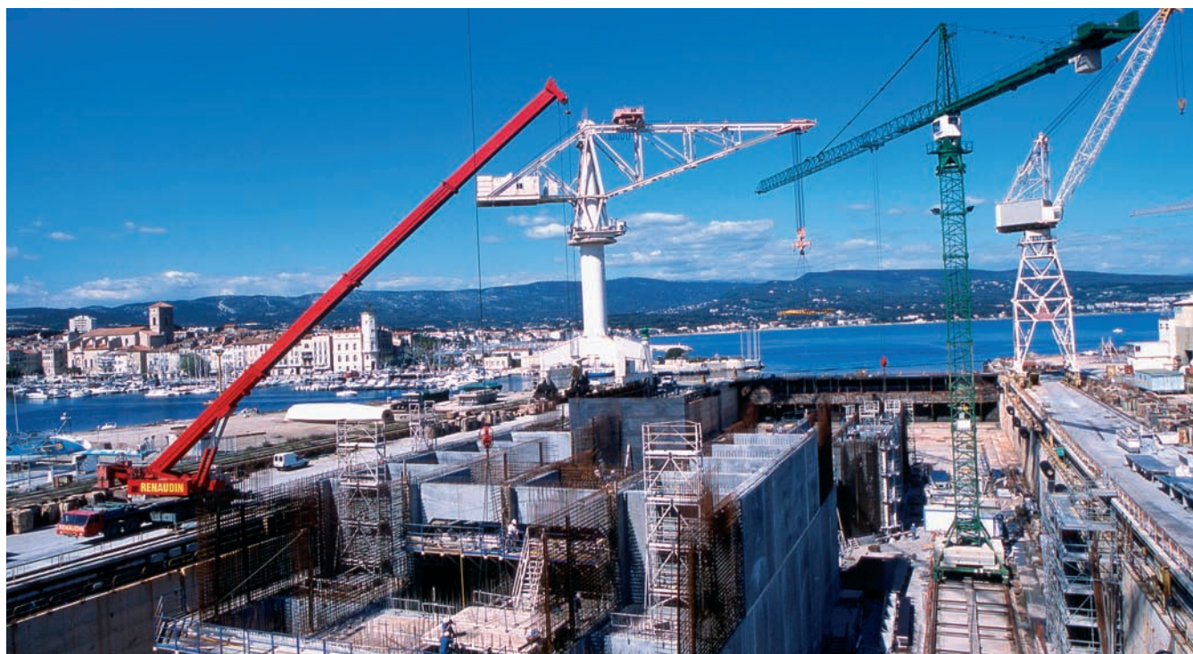
Chantier en site maritime.
