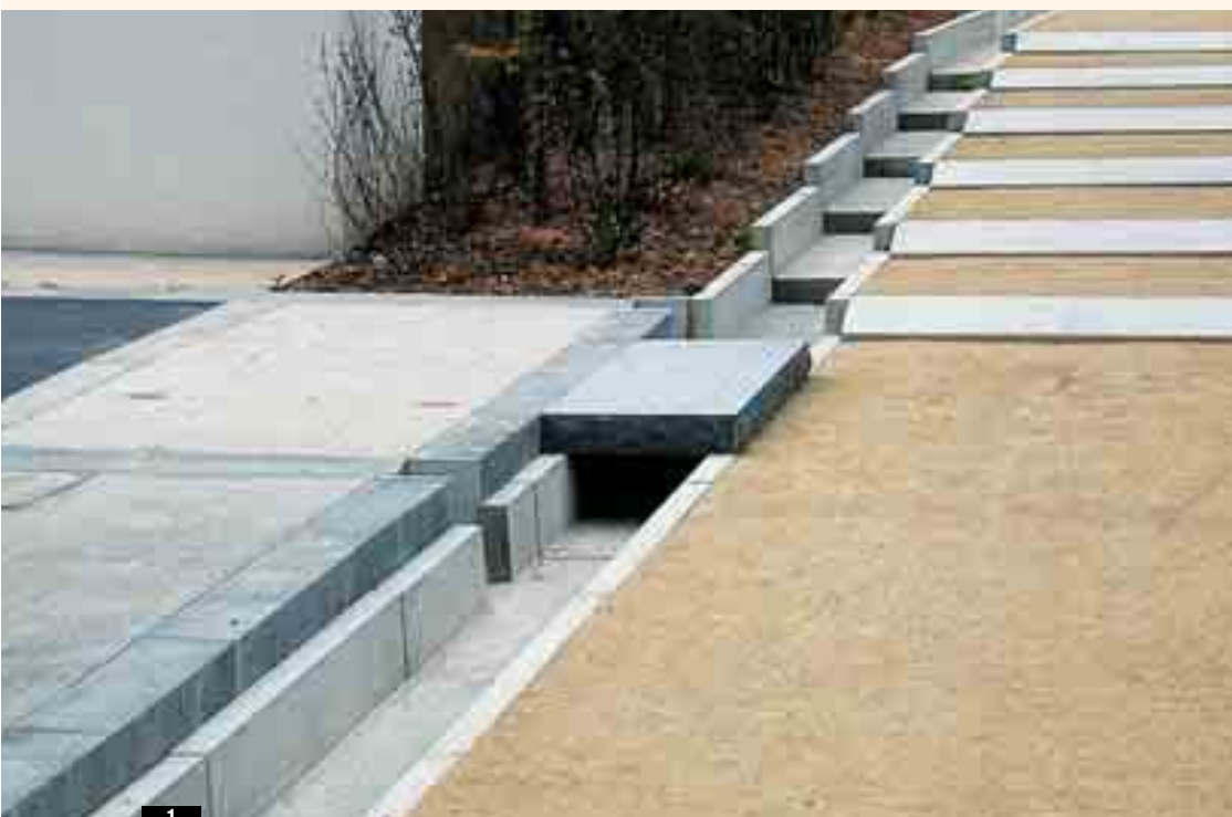
>>> 1 Des chemins d'eau en béton préfabriqué recueillent les eaux pluviales et structurent les quartiers d'habitat.
