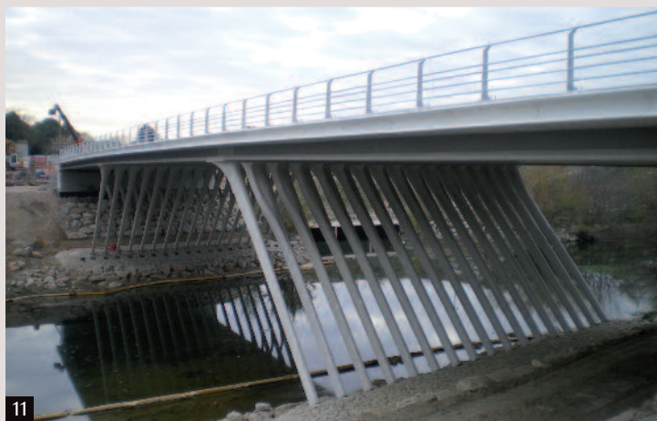
→ 10 et 11 • Le pont de la République à Montpellier (34), photos : Patrick Guiraud.
