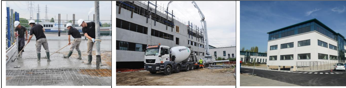
Bétonnage de la dalle terrasse
