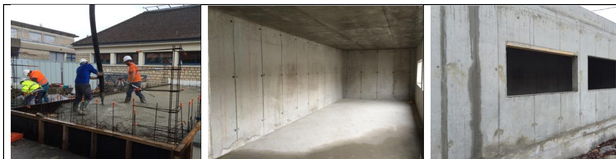
Coulage du béton recyclé
