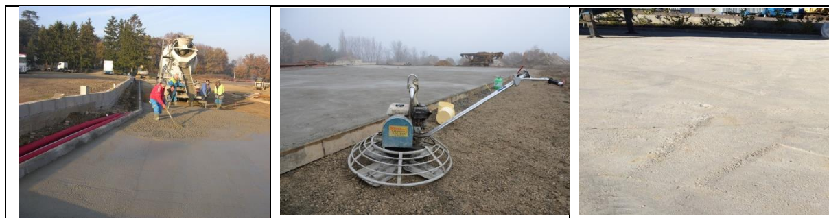
Coulage du béton recyclé
