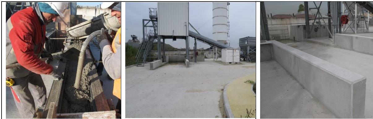
Coulage du béton recyclé
