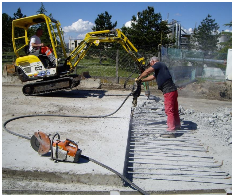
Photo 16 : Dégageant d'armatures de béton armé continu
