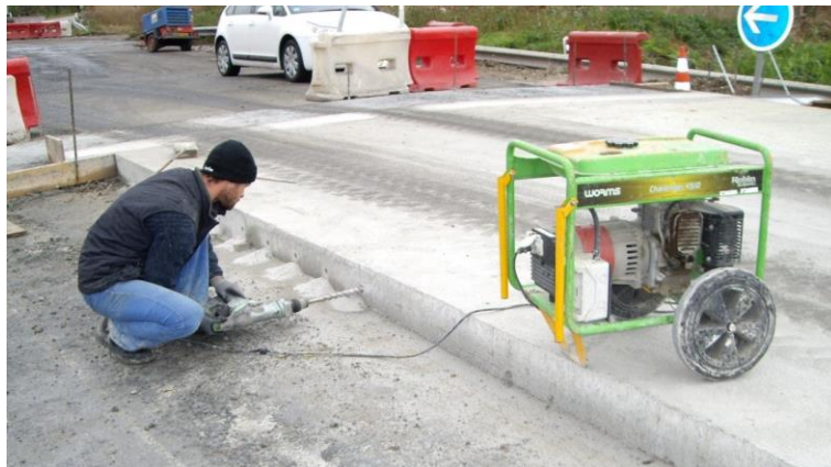
Photo 17 : Forage pour ancrage de barres d'aciers
