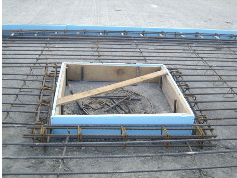
Photo 11 : Réservation autour d'un regard de visite
