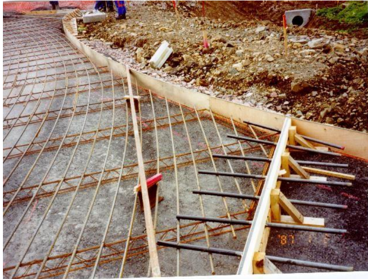
Photo 13 : Exemple de ferrailage entre l'anneau et l'amorce de chaussée pour un giratoire en BAC (Crédit photo G. Laurent, SPECBEA)
