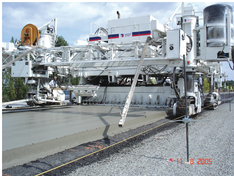
Mise en œuvre du béton armé continu à l'aide d'une machine à cofrage glissant sur une fondation en grave bitume.
